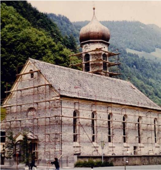
*1981 wurde der alte Putz abgeschlagen, was für kurze Zeit einen Blick auf das Steinmauerwerk ermöglichte. Diese unkoordinierte Maßnahme verursachte damals allerdings ein schweres Zerwürfnis zwischen Bgm. Alfons Kohler und dem Denkmalamt*
